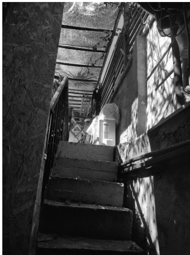
Cortile _ scala esterna
