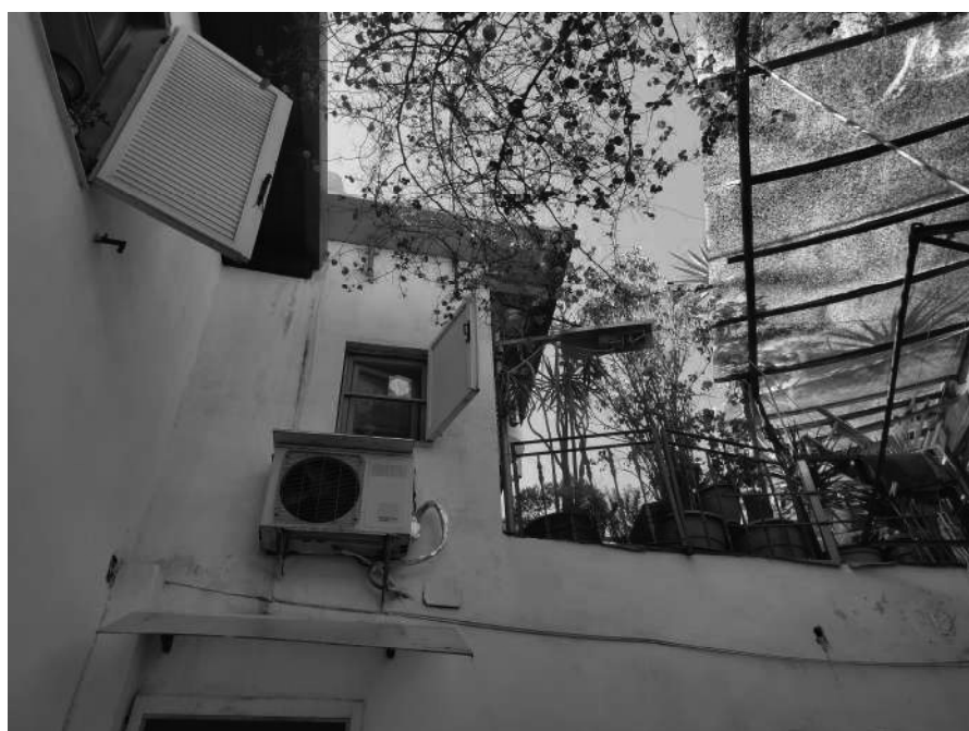
Cortile _ terrazza e copertura
