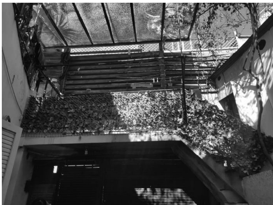
Cortile _ scala esterna
