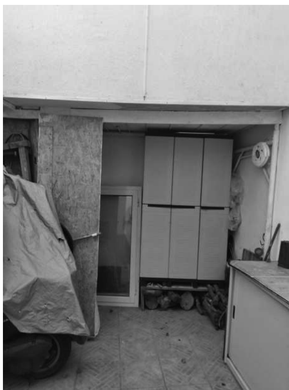
Cortile _ locale di sgombero
